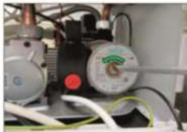
2. Отвинтите центральный винт с помощью отвертки
